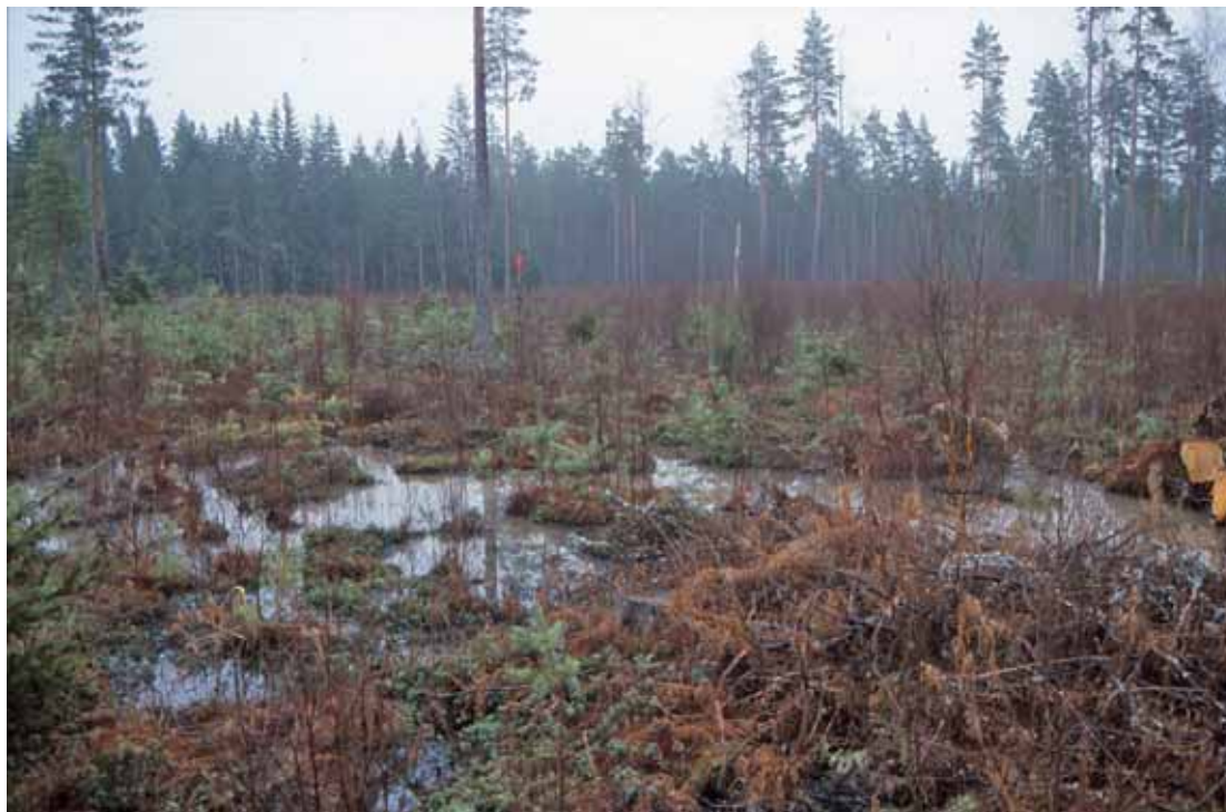
Kuva 6. Pyhäjärveen laskevan Muurassuonojan pintavalutuskenttä, joka toteutettiin 2002 Lounais-Suomen metsäkeskuksen kunnostusojitushankkeen yhteydessä. Kuva: Timo Silver.
