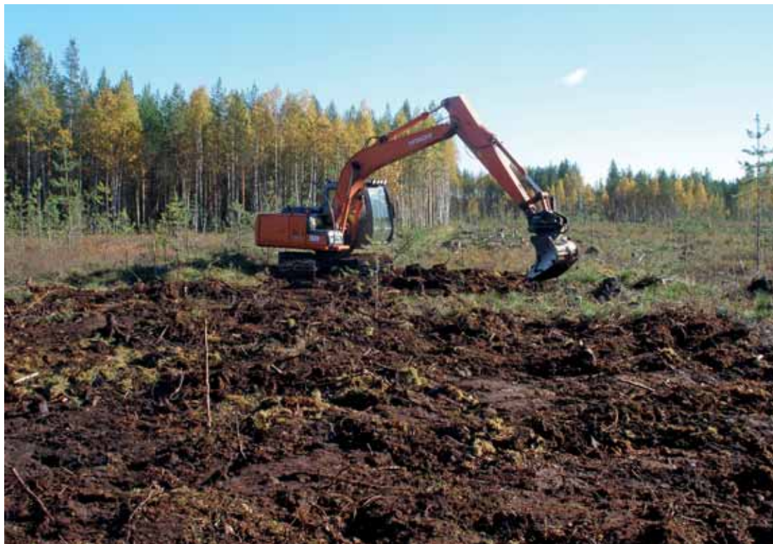
Kuva 5. Kaivukone Metsähallituksen ennallistamistöissä Virtain Haukkanevalla syksyllä 2010. Ennallistaminen toteutettiin tehokkaasti ojat tukkimalla ja lisäksi rakennettiin padot määräväleihin. Kuva: Timo Silver.
