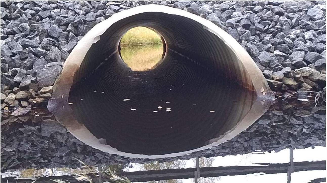
Hyväkuntoinen uusi pinnoitettu teräksinen putkisilta, luiskakiveyksiä kannattaa seurata Kuva: Hannu Ulvinen
