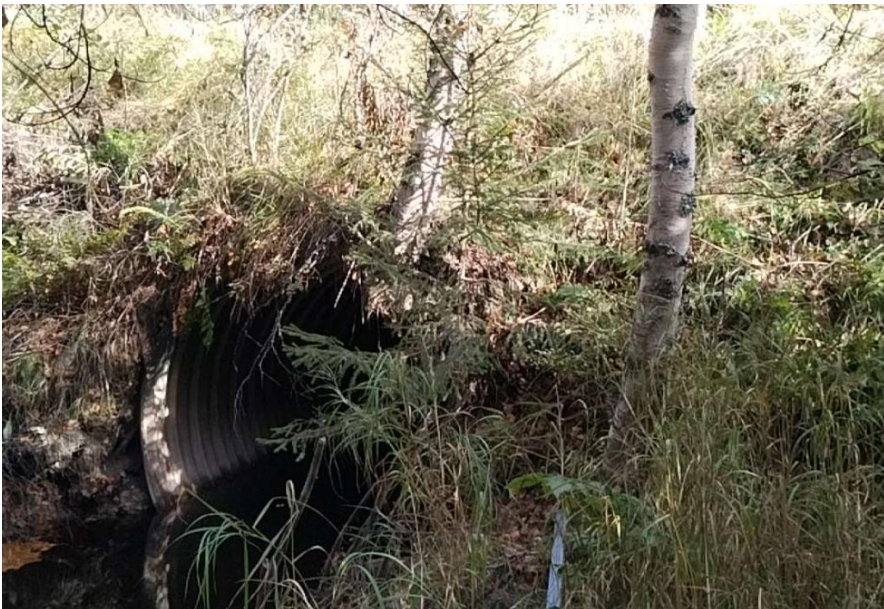
Puuston juuristo vahingoittaa teräsrumpua, se on syytä poistaa.
