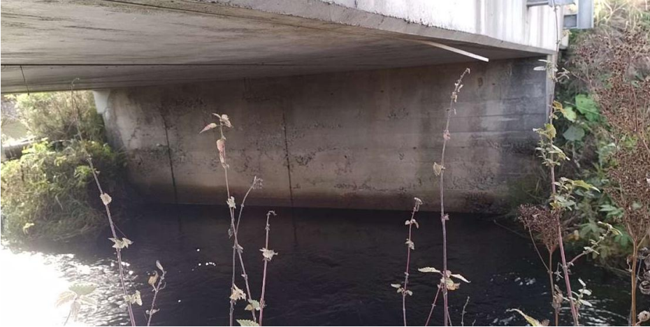
Hyväkuntoinen maatuki- ja perusrakenne.
