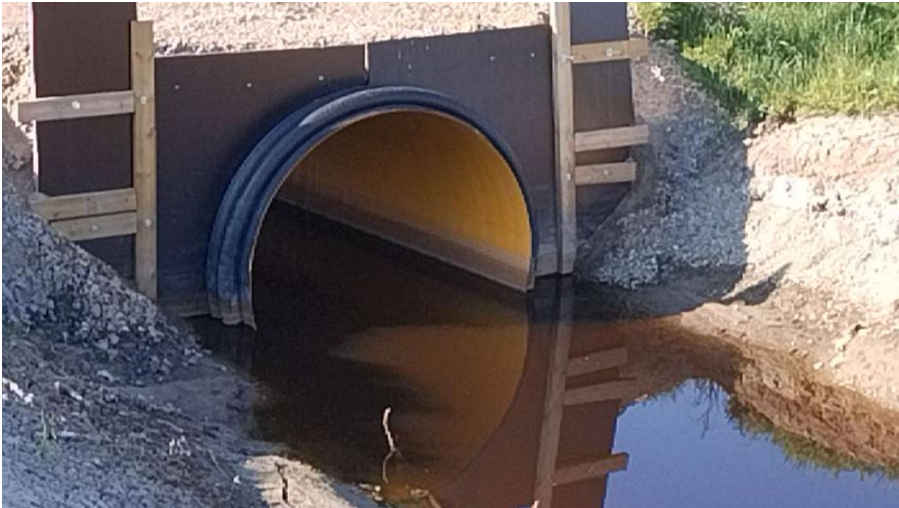
Muovirummun päähän on rakennettu valumisen estävä tuenta.
