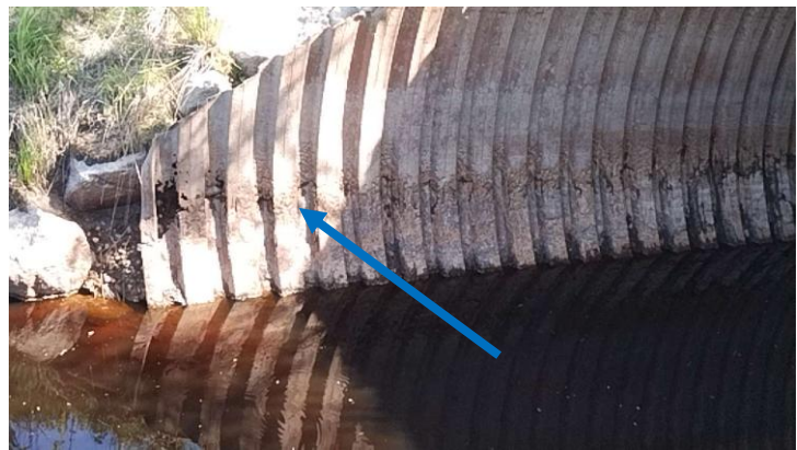
Hyväkuntoinen uusi pinnoitettu teräksinen putkisilta, luiskakiveyksiä kannattaa seurata Kuva: Hannu Ulvinen
