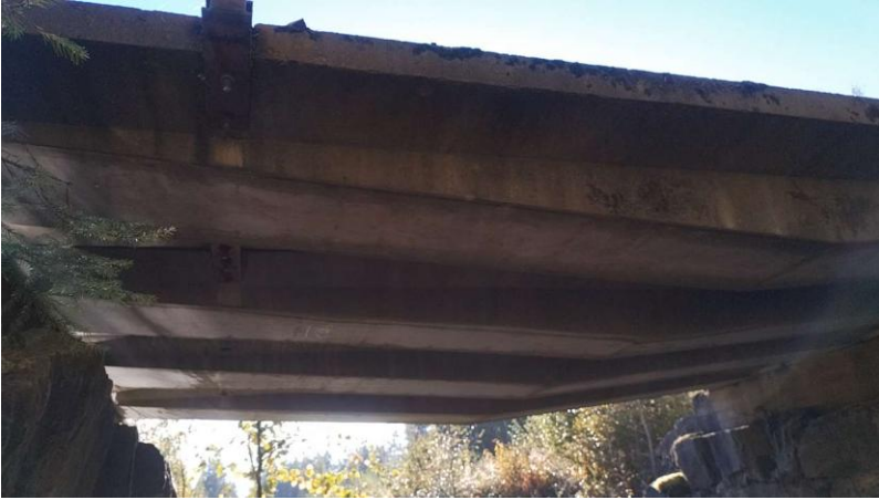
Jämy- maatilasilta (mahapalkkisilta).
