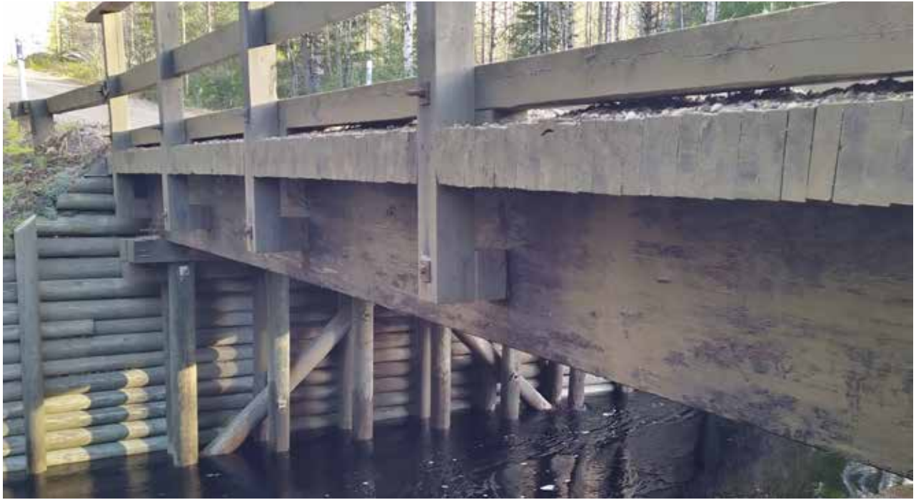
Betonelementtisilta (BLE2) varustettuna puukaiteilla.
