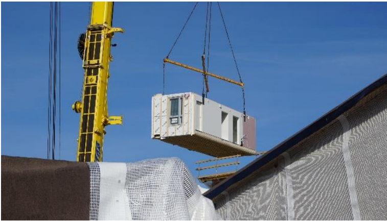
CLT -tilaelementti Julkulan puukerrostalotyömaalla
