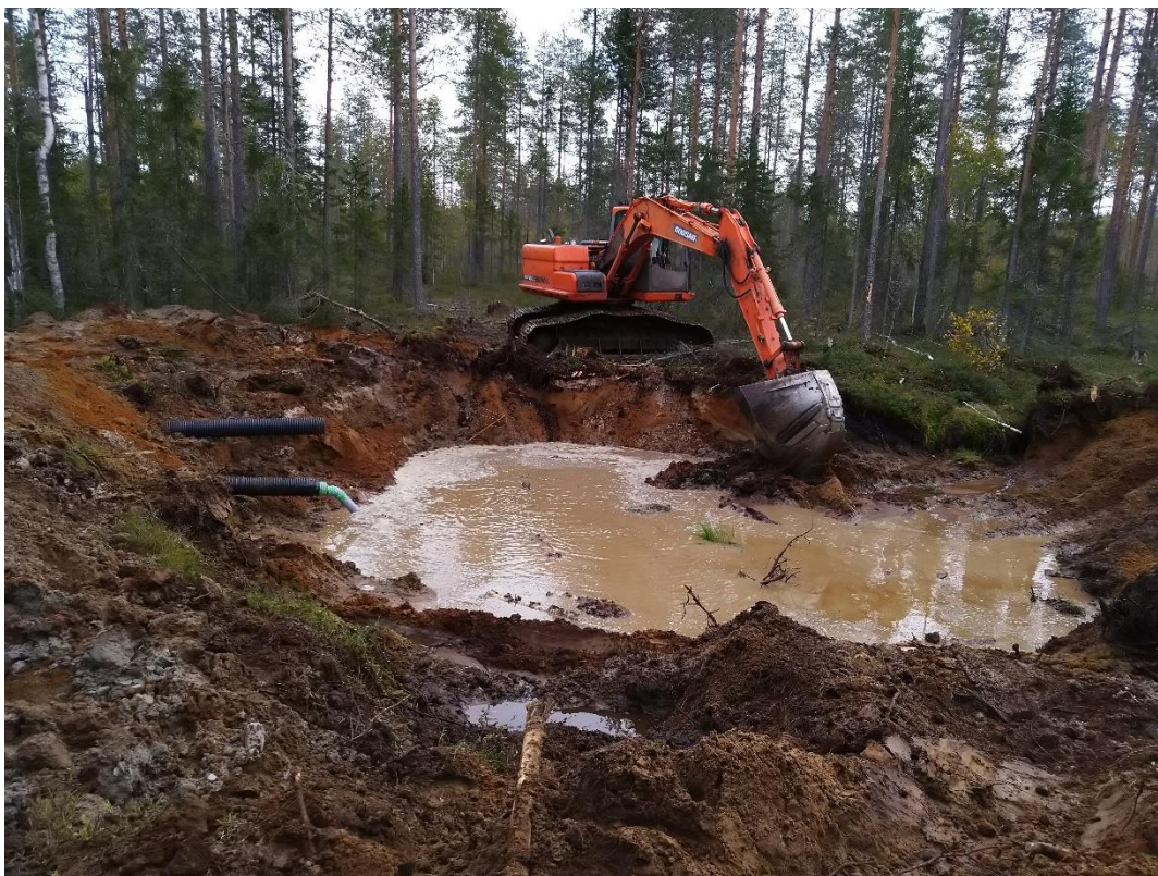
Kuva 7 Laskeutusallas putkipadolla alkaa olla valmis.
