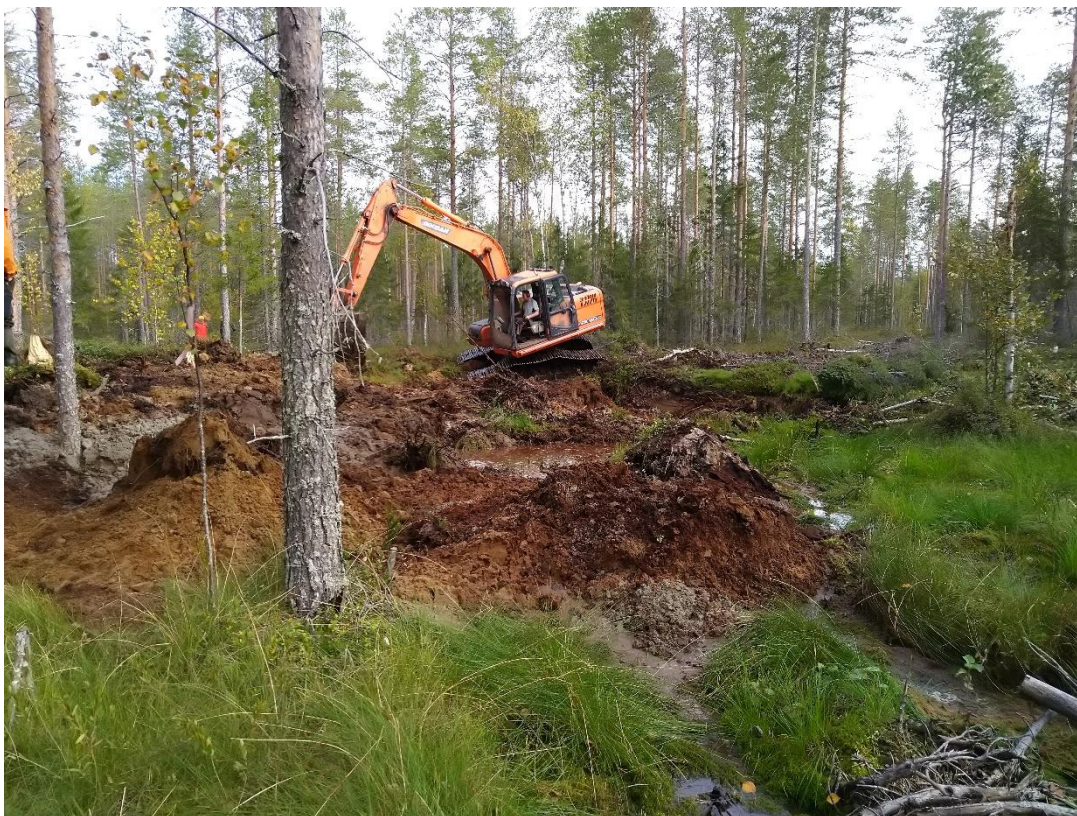
Kuva 6 Laskeutusaltaan kaivaminen suolle.
