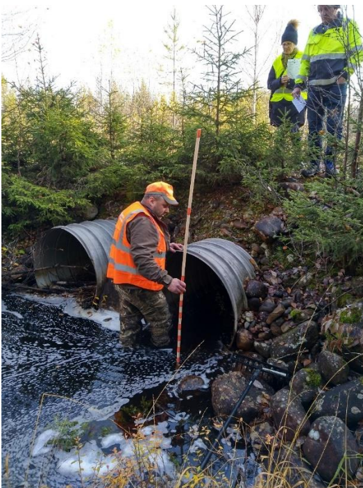
Kuva 3 Rumpuesteen mittausta maastossa.
