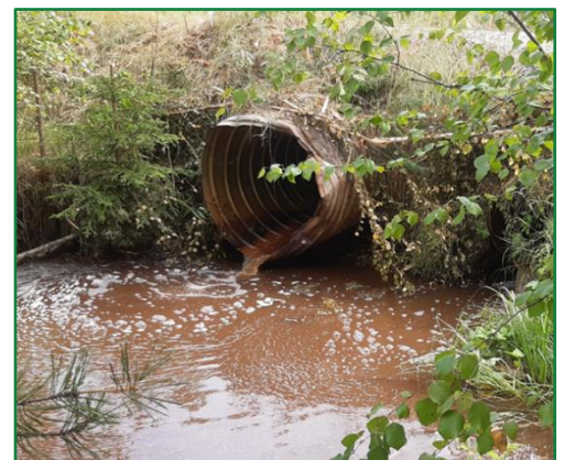
Kuva 2: Vaellusesteenä oleva rumpu
